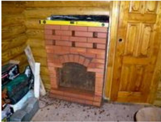
Прежде чем приступать к кладке, убедитесь в том, что основание, на котором стоит металлическая печь, выдержит вес обкладочных кирпичей. При значительных размерах железной печи он может достигать нескольких сотен килограммов.
